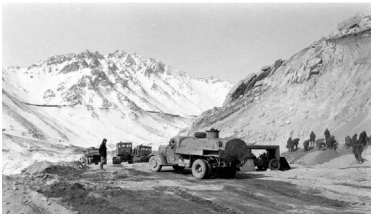
Строительство Саланга, 1960 год/ © afghanistan.ru
